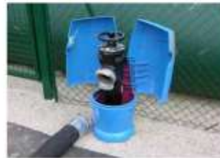
Poteau d'aspiration de 100 mm
