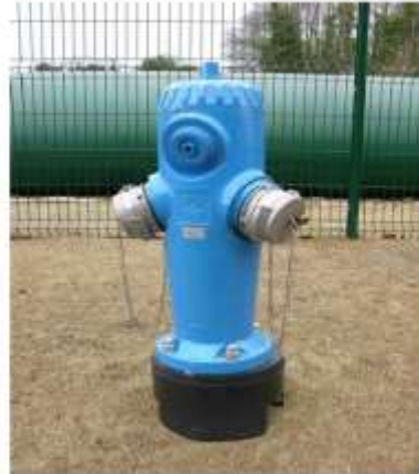
Poteau d'aspiration de 150 mm, muni de deux sorties de 100 mm et d'un carré de manoeuvre
