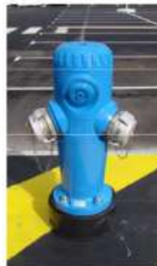
Poteau d'aspiration à réseau sec de 150 mm, muni de deux sorties de 100 mm et d'un Aircap. Pas de carré ni de volant de manoeuvre
