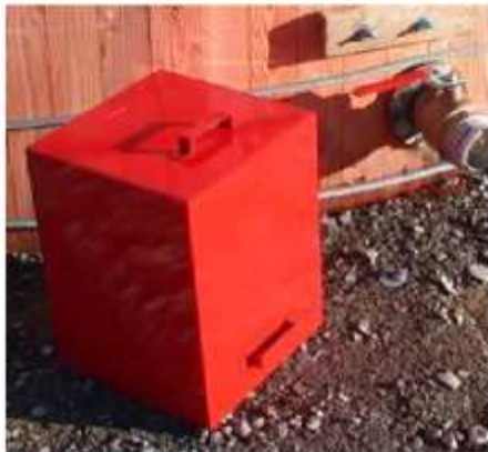
Prise directe de 100 mm sur réserve d'eau incendie aérienne.
