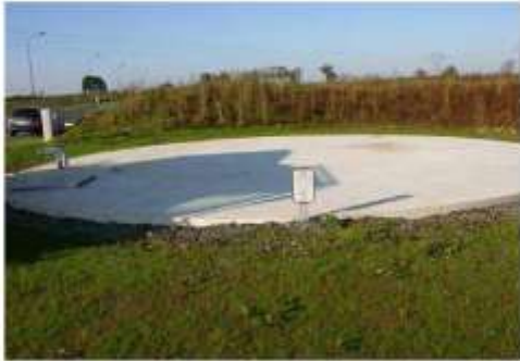
Réserve d'eau enterrée
