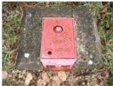
Bouche de lavage fermée
