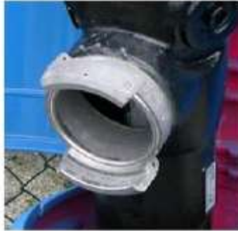
Poteau d'aspiration de 100 mm, muni d'une sortie de 100 mm, avec raccord fixe
