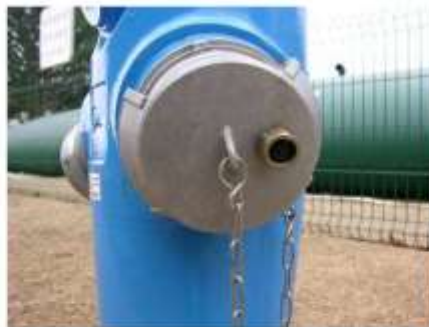
Poteau d'aspiration de 150 mm muni d'un Airclap
