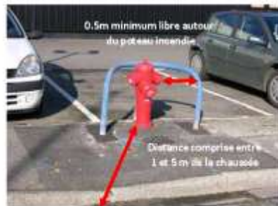
BARRIERE DE PROTECTION D'UN POTEAU D'INCENDIE - Schema de principe -
