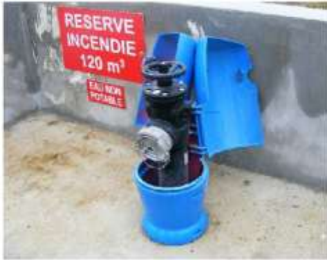
Poteau d'aspiration de 100 mm, muni d'une seule sortie de 100 mm et d'un volant de manoeuvre
