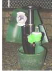
Intérieur d'une borne de puisage avec 1/2 raccord de 65 mm et compteur d'eau
