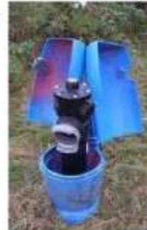
Poteaux d'aspiration de 100 mm à réseau sec, munis d'une seule sortie de 100 mm. Pas de volant ni de carré de manoeuvre.
