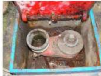
Bouche Incendie de 80 mm à raccord Keyser
