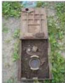
Bouche Incendie de 80 mm à tenon
