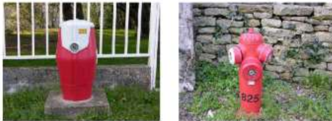
Exemples de numérotation de poteaux incendie
